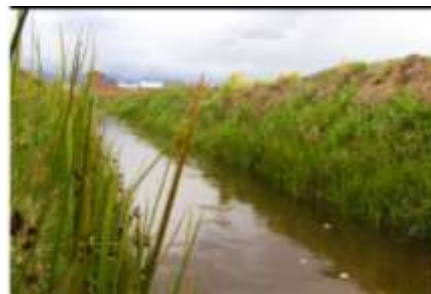
Canal de Riego en Tierra
