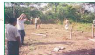
2.- Delimitación del área y apertura de pozos para instalación de postes.
